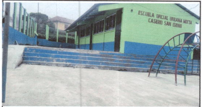
Foto 2: Reparación de planchas de concreto de patio
